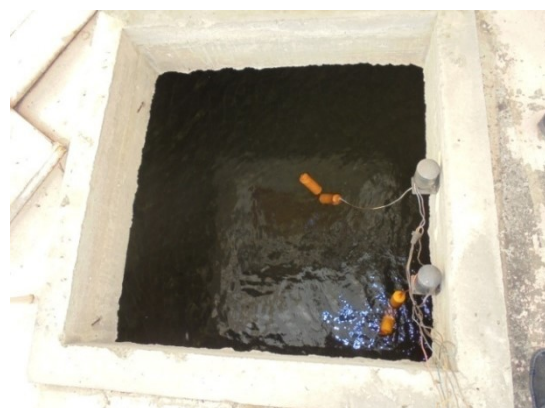
ภาพที่ 4-5 ถังลำร่อนน้ำได้ดิน เปลี่ยนอุปกรณ์ข้อต่อต่างๆ และอยู่ในสภาพดี ไม่มีรั่วซึม และถังลำร่อนน้ำชั้นดาดฟ้า
