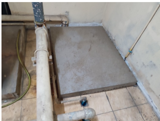
ภาพที่ 4-5 ถังลำร่อนน้ำได้ดิน เปลี่ยนอุปกรณ์ข้อต่อต่างๆ และอยู่ในสภาพดี ไม่มีรั่วซึม และถังลำร่อนน้ำชั้นดาดฟ้า
